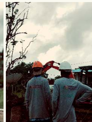
Saël et Emanuelle - de Maripasoula - volontaire chantier
