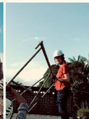
Alyzée - de Bruxelles - volontaire chantier
