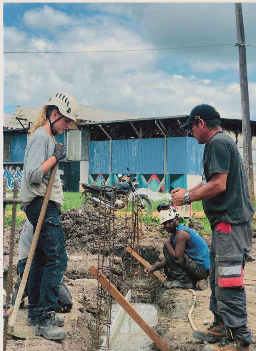
Chantier de la maison de la famille Panapuy yalallicantier avant dernier jour.
